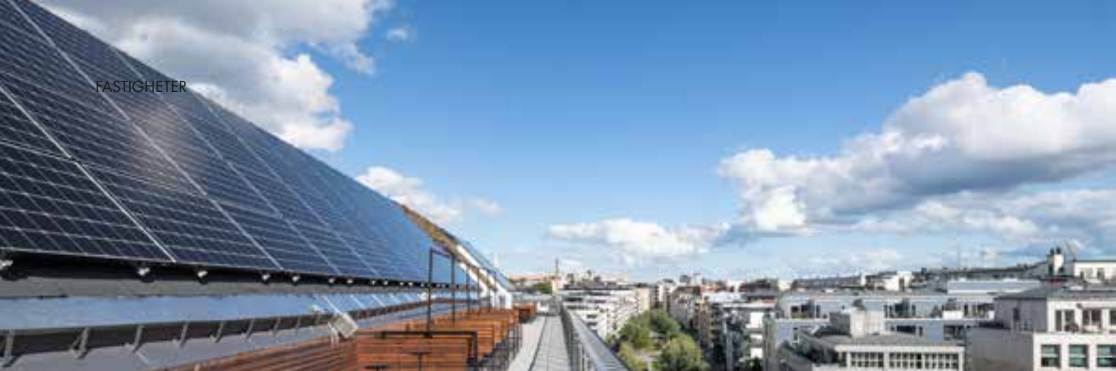
↑ Sedumiak och solpanel på Hammarbyterrassen – Goodbye Kansas nya kontor i Hammarby Sjöstad.
