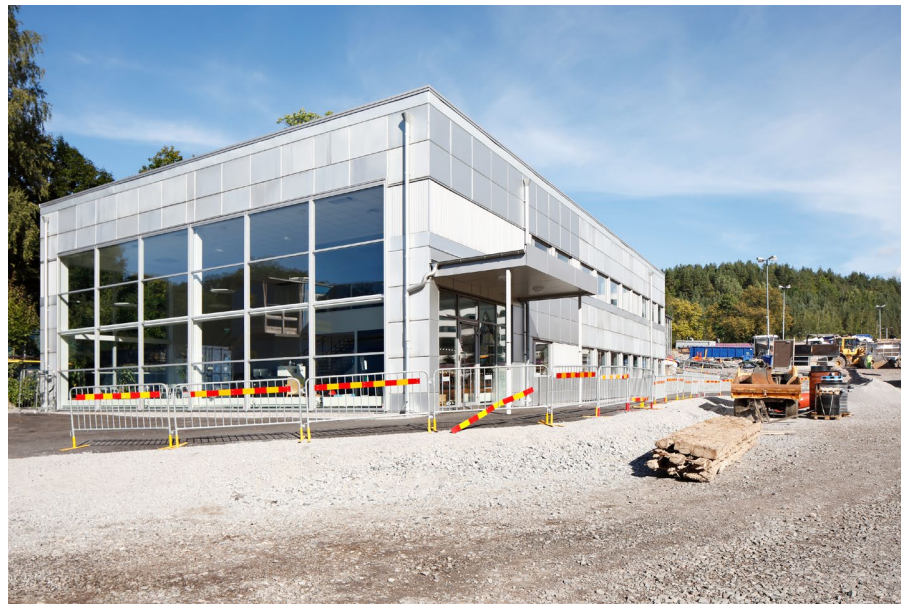
Hållbarhetshuset – byggetablering i Haga Norra. Byggnaden är till 70% uppförd med återbrukat material. All inredning återbruk.
