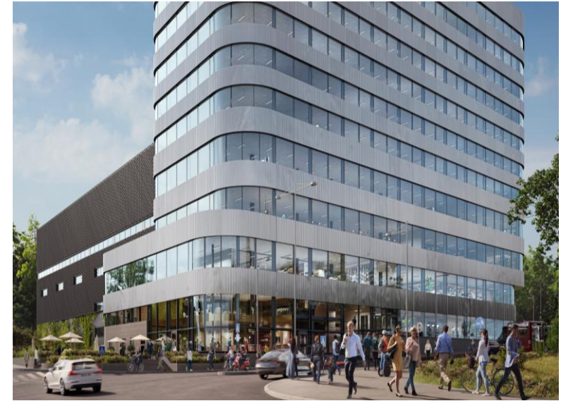
Alfa Laval (Separatorn 1), Flemingsberg
